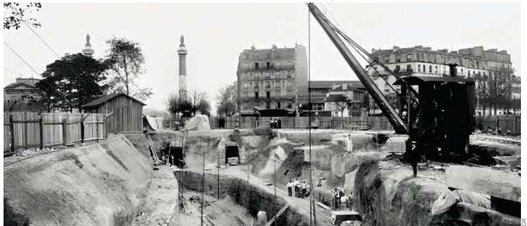
Travaux d'aménagement de la station Nation en 1901.
