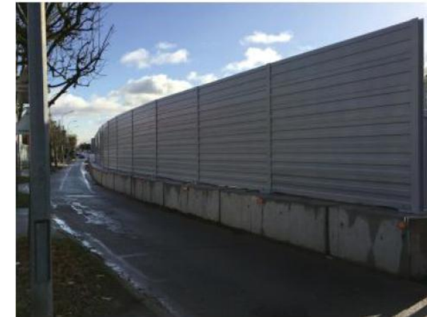
Exemple de clôture acoustique
