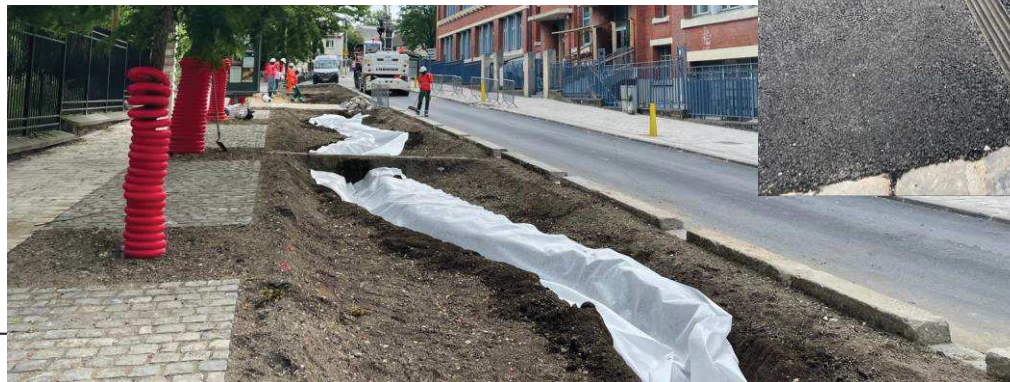
Noue urbaine avec muret de bief et rappel du méandrage d'ancien ru
