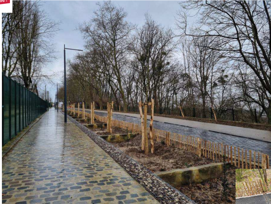
Noue urbaine avec muret de bief
