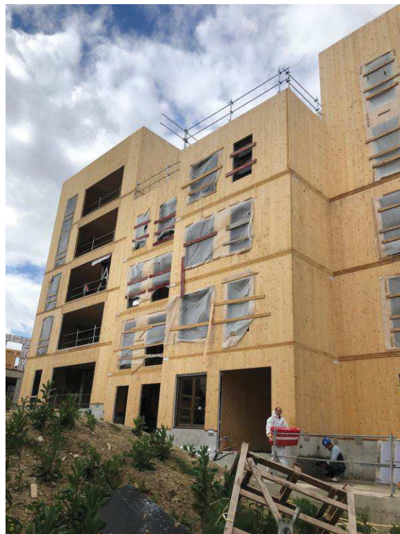
Visite de chantier mai 2021
