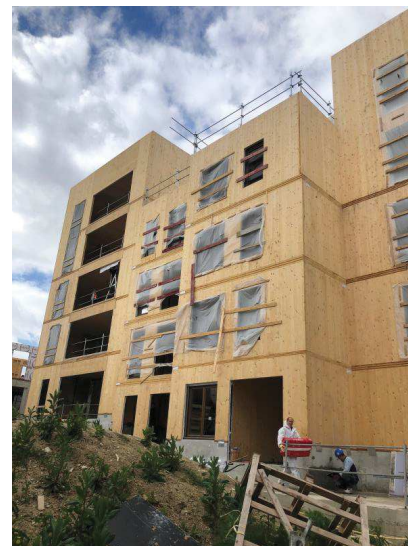
Visite de chantier mai 2021
