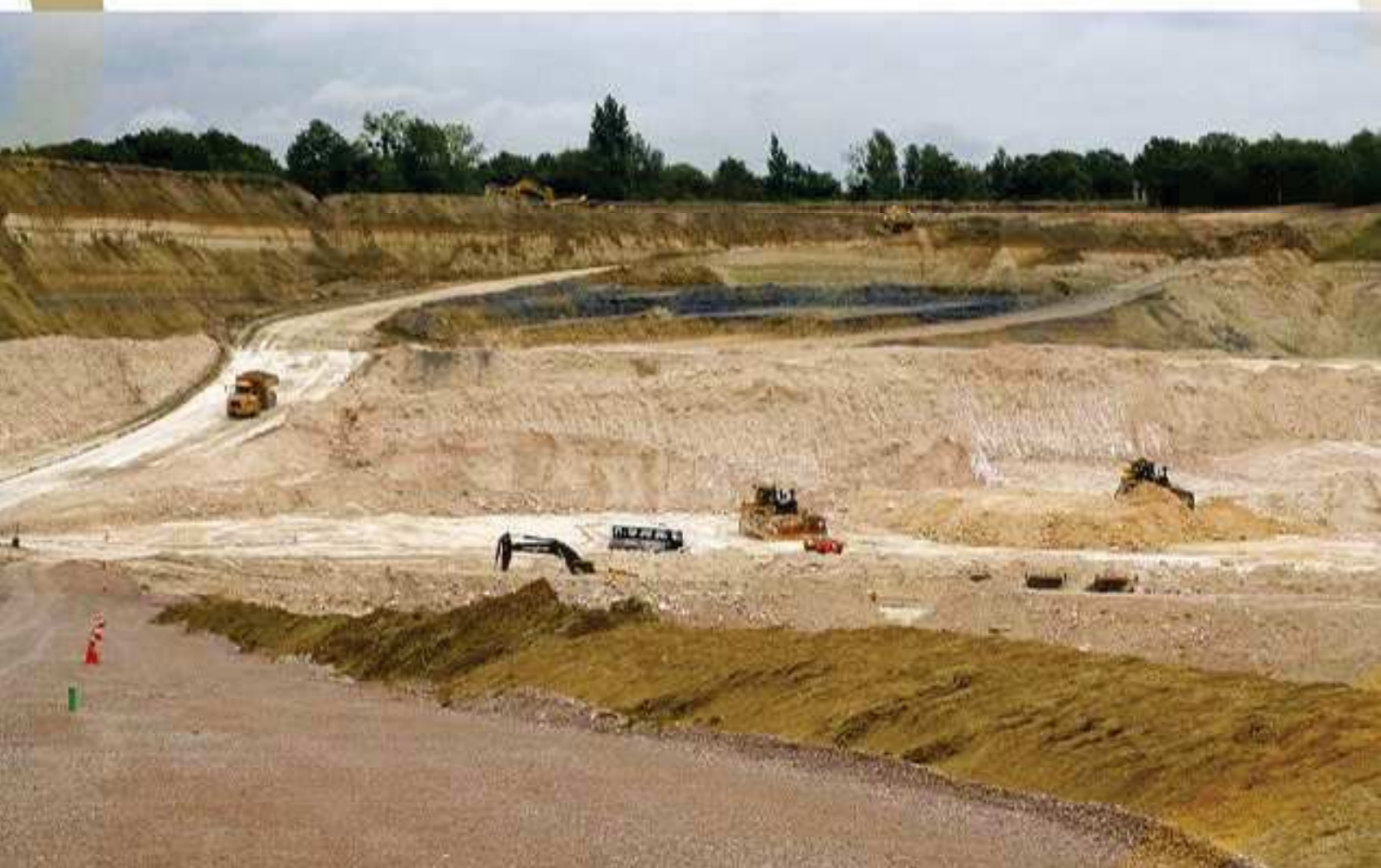
Une carrière de gypse à ciel ouvert en cours d'exploitation. Carrière Placoplatre à Villeparisis © Adenca
