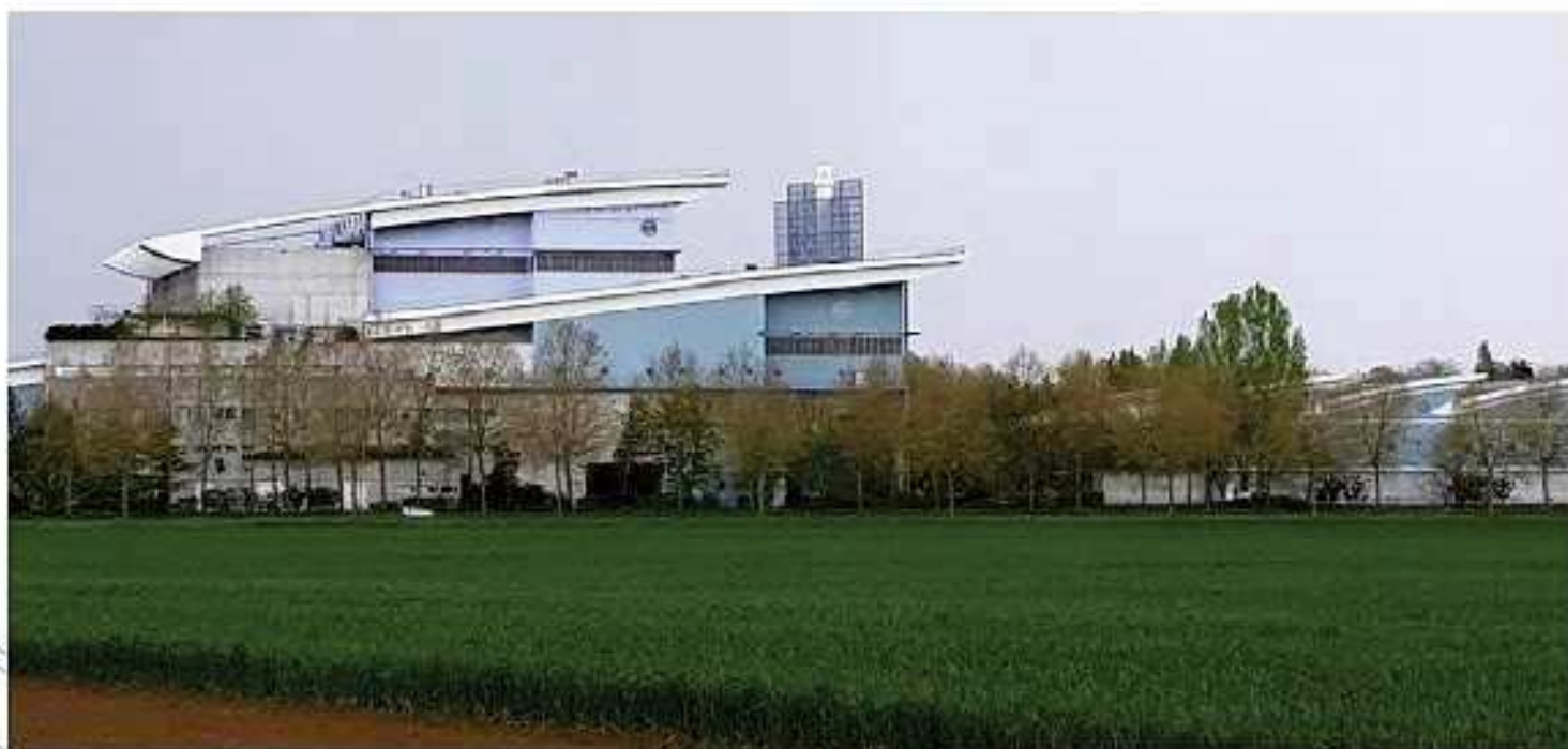
L'Unité de valorisation énergétique (UVE) de Vaux-le-Pénil, état actuel © JL Eyraud
