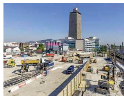
Chantier Gare Pleyel, Saint-Denis
