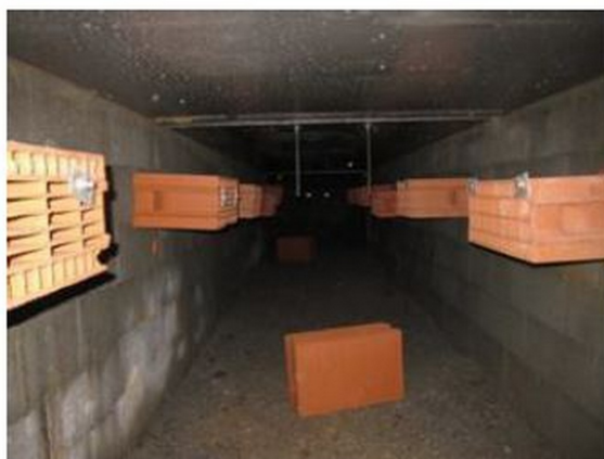
Figure 87. Exemple de supports de gîte (briques plâtrières) posées en hauteur sur les murs d'une galerie souterraine (source : Denis Lafage - CEN Pays de la Loire)
