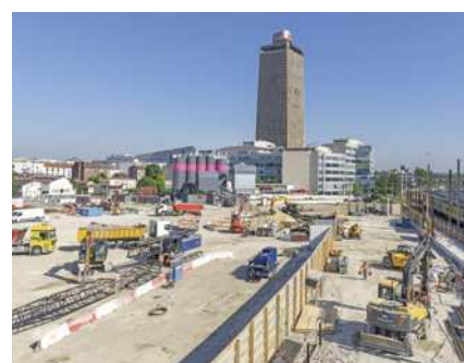
Chantier Gare Pleyel, Saint-Denis
